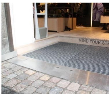
Livello pavimento, pronto per l'accesso/uscita
